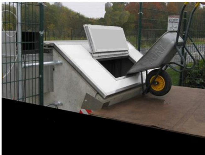
Abbildung 27: Befüllen des Containers von der Hofstelle; Trennung von Tierhaltung und Abholung ©LMG Nord
